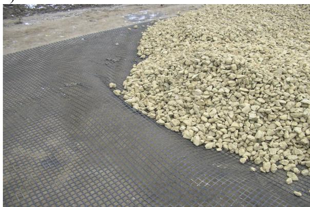
Рисунок 7.2 – Отдельные рабочие операции при армировании дорожных одежд: а – укладка георешетки; б - отсыпка материала несущего основания; в – разравнивание материала по способу «от себя»; г – образование «волны» перед разравниваемым слоем
